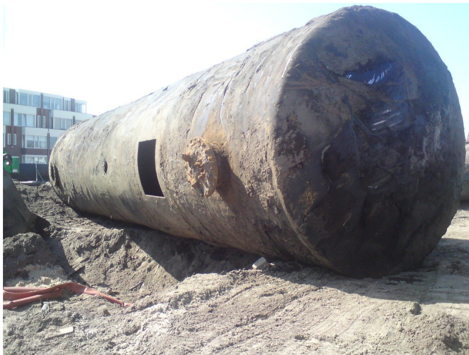
Deliterrein, verwijderen ondergrondse opslagtank
