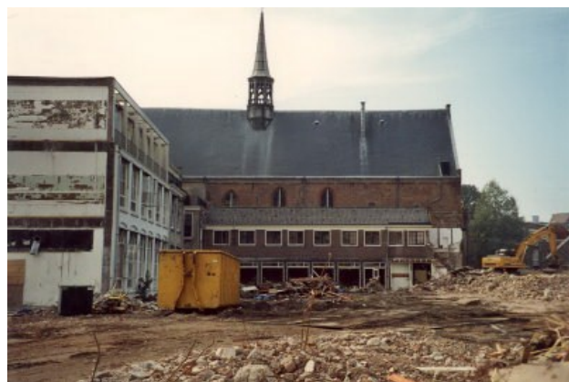
Voorbereiding sanering Janskliniek
