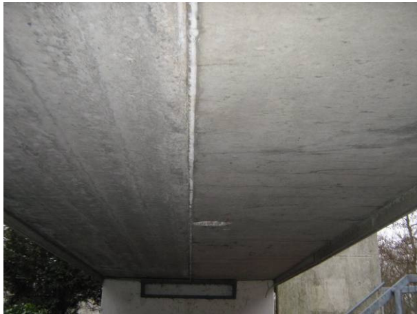
Foto 1: Prefab element met onderling kleurverschil
