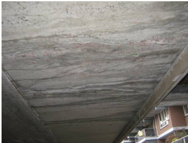
Overzicht gescheurd prefab element
