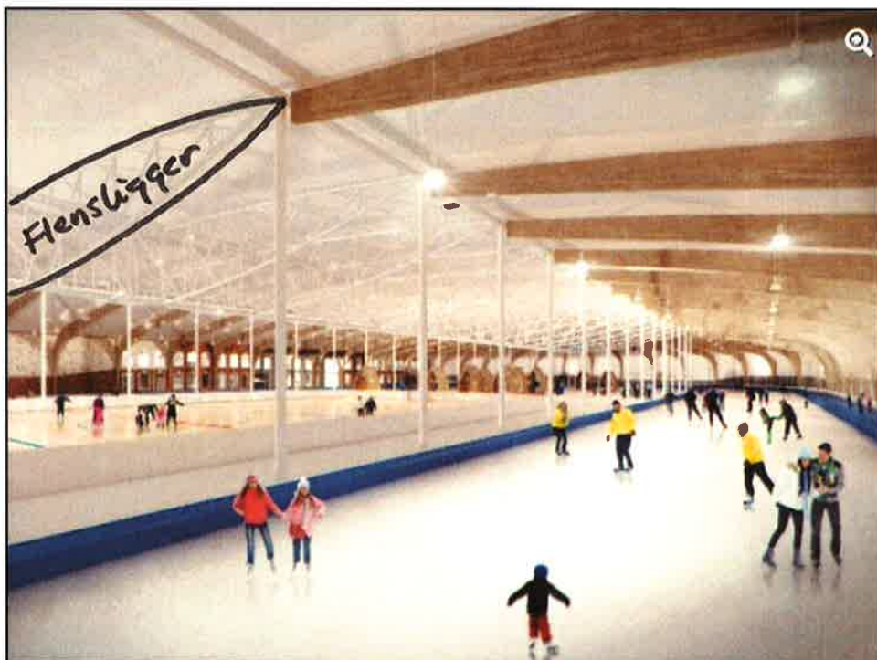
Bij toepassing van deze constructie kan overkapping 3 m. Lager !
