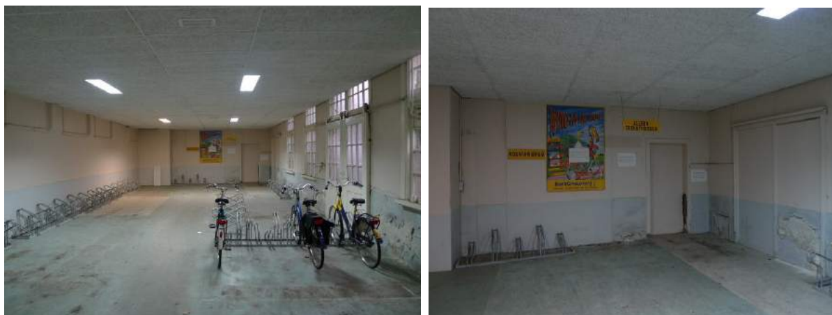
De ruimte op de begane grond gezien richting het westen.
