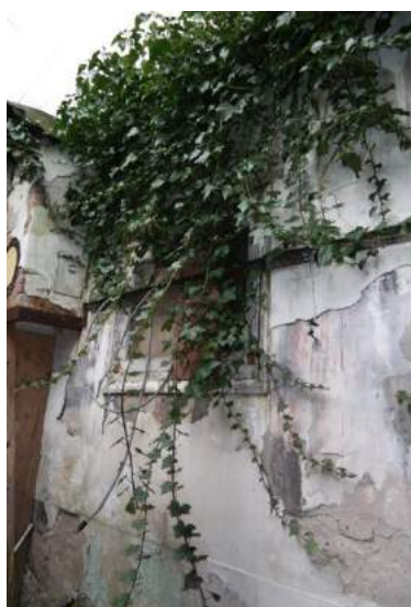
Binnenzijde gevel bergruimte.
