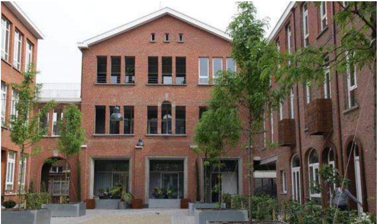
Ingrepen in de gevel laten oude structuur wel zichtbaar
