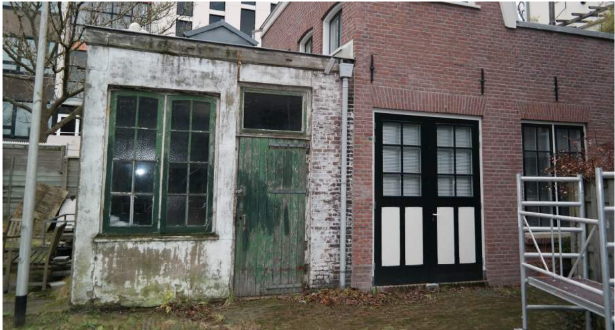
Zuidoostgevel van de voormalige machinekamer
