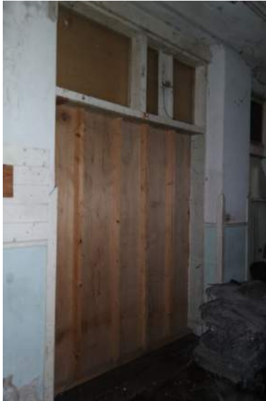
Dichtgezette doorgang tussen het ketelhuis en de wasserij gezien aan de zijde van het ketelhuis.
