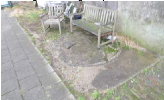
Betonnen plaat bij de zuidwestgevel.
