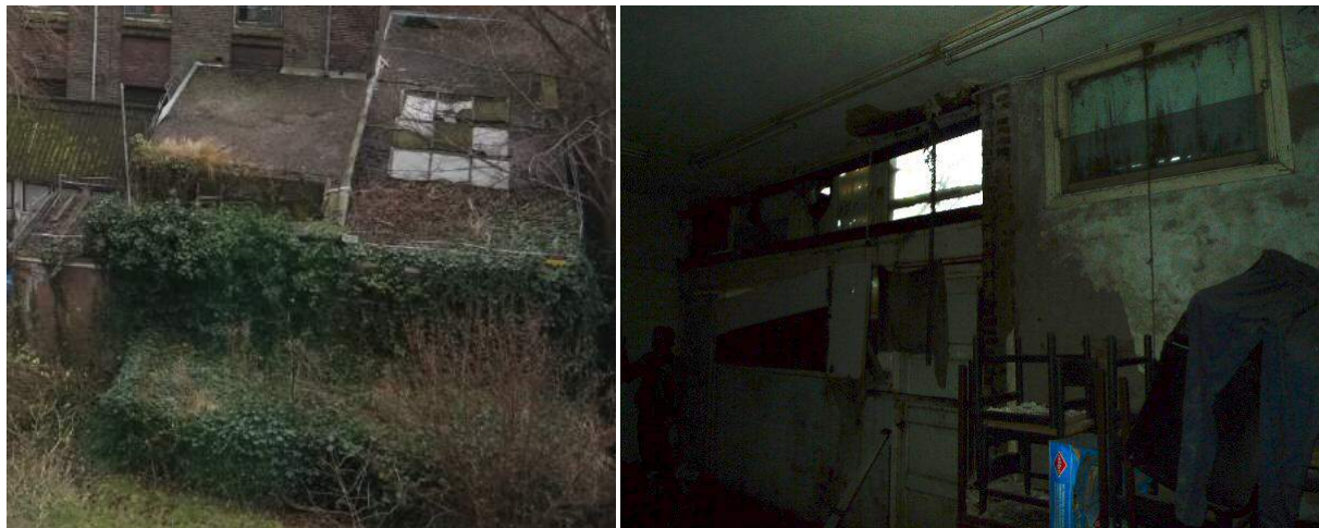
Links; het dak van het ketelhuis en de machinekamer. Rechts; binnenzijde van de zuidwestgevel van het ketelhuis.
