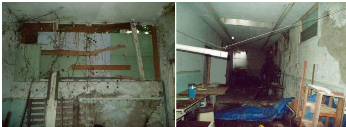
Binnenzijde noordwestelijke gevel van het ketelhuis.
