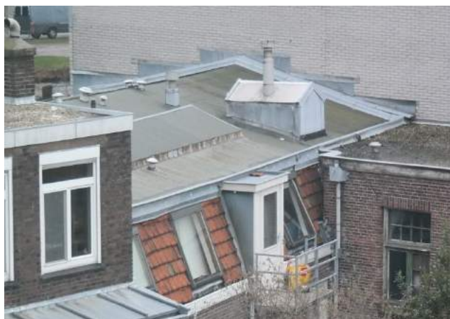
Dakvlakken ten zuidwesten van de nok.
