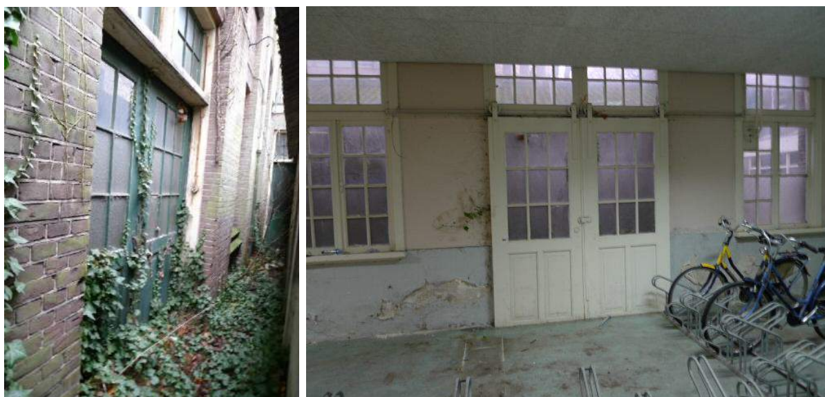
Dubbele schuifdeur in de noordwestgevel gezien van buiten en binnen.
