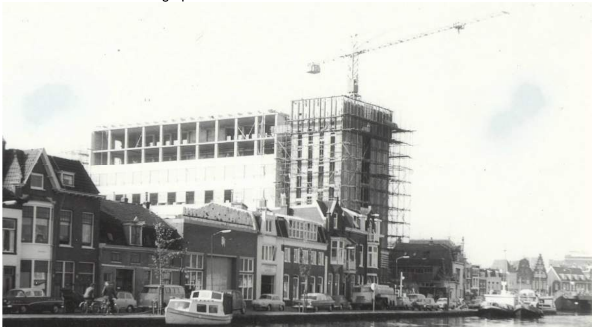
Foto van de bouw 1966
