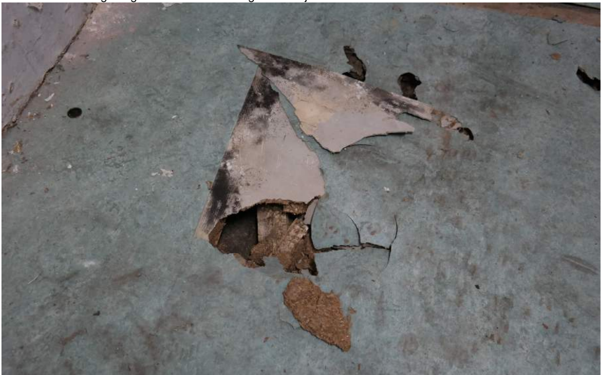
Detailfoto van de vloer.
