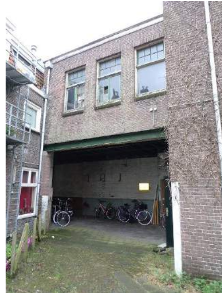
Aansluiting wasserijgebouw met doorgang.
