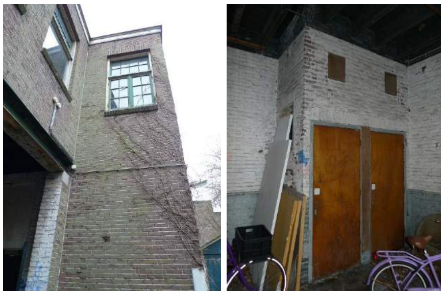
Links; noordoostgevel. Rechts; voormalige toilethokken.
