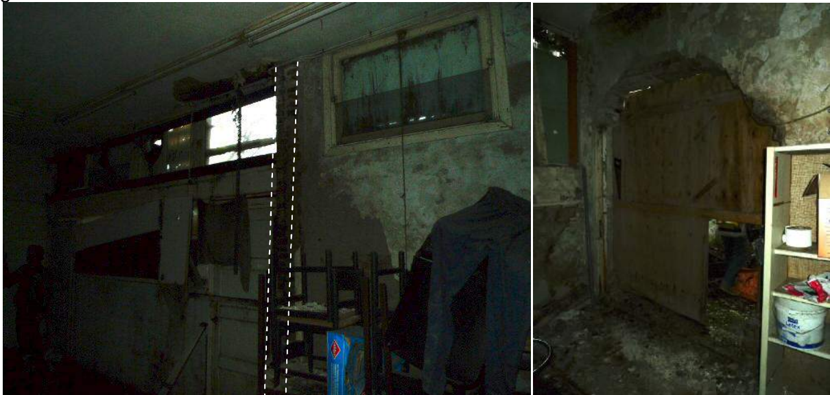
Links; sporen van het verlengen van het ketelhuis. Rechts; het gat dat gemaakt is tussen het ketelhuis en de berging.
