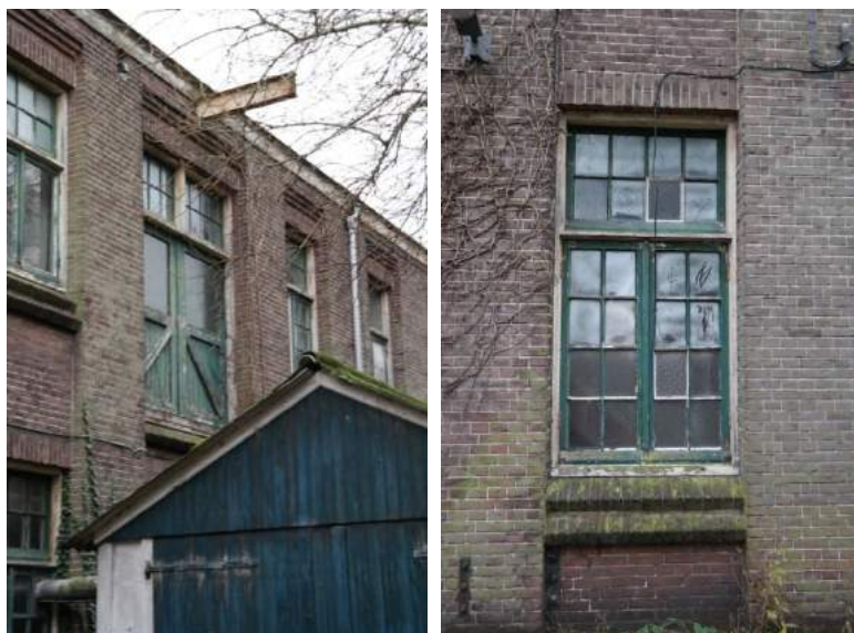
Links; de dubbele schuifdeur in op niveau van de eerste verdieping. Rechts; raamkozijn in de noordwestgevel.
