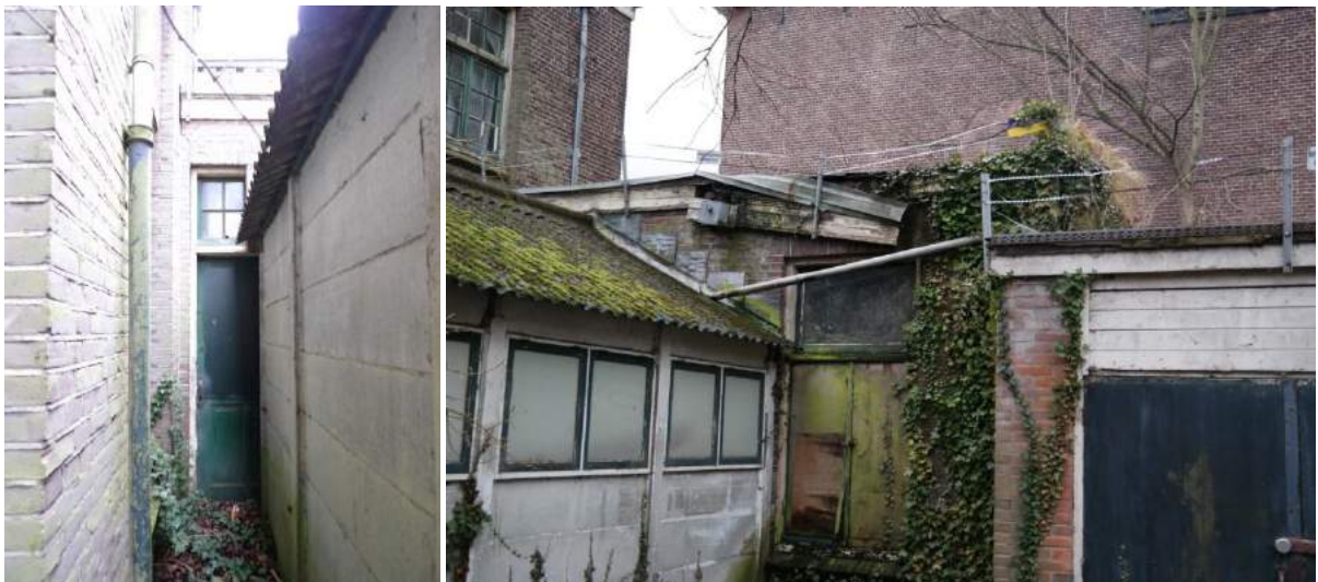
Gevel machinekamer links en rechts van de expeditieloods.
