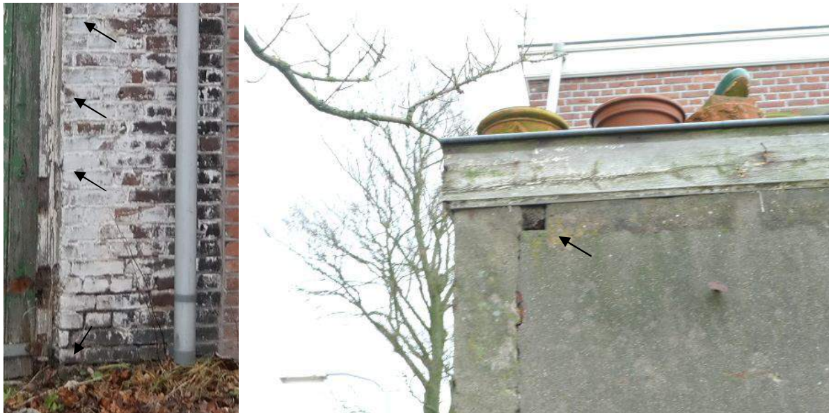
Links; halve koppen in het metselwerk van de zuidoostgevel. Rechts; sparing in de zuidwestgevel.
