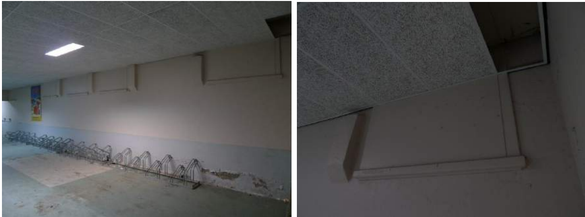
De dichtgezette ramen op begane grondniveau van de zuidoostgevel.
