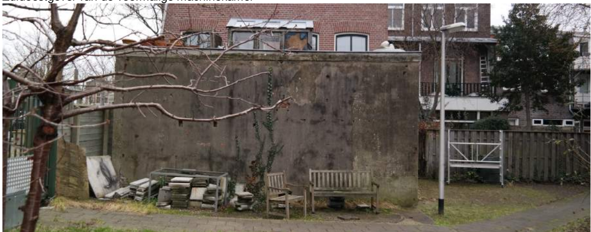
Gepleisterde zijgevel van de voormalige machinekamer
