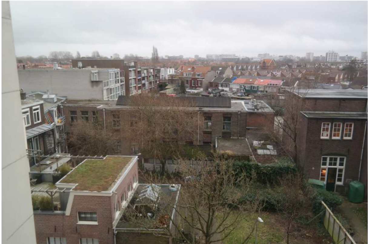
Het hele achterterrein vanaf Koningstein gezien. In het midden de wasserij, rechtsdaarvoor de machinekamer, rechts ernaast het ketelhuis, beiden met klimop begroeid. In het midden voorin het dak van de aanbouw achter nr 24.
