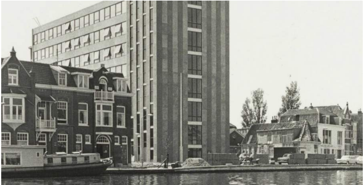
Het nieuwe kantoorgebouw van Openbare Werken tussen de oudere bebouwing aan de Zuider Buiten Spaarne. Rechts is het gespaarde Koningstein-woonhuis Zuider Buiten Spaarne 18 nog te zien.
