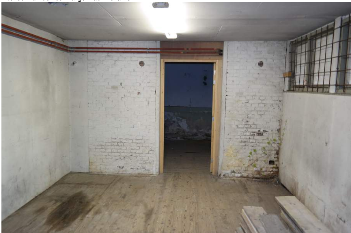
Interieur van de betonnen expeditieloods die koud tegen de machinekamer is geplaatst.
