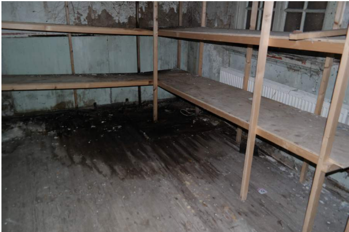
Interieur van de voormalige machinekamer
