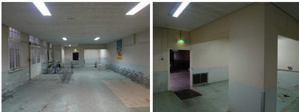
De ruimte op de begane grond gezien in oostelijke richting.
