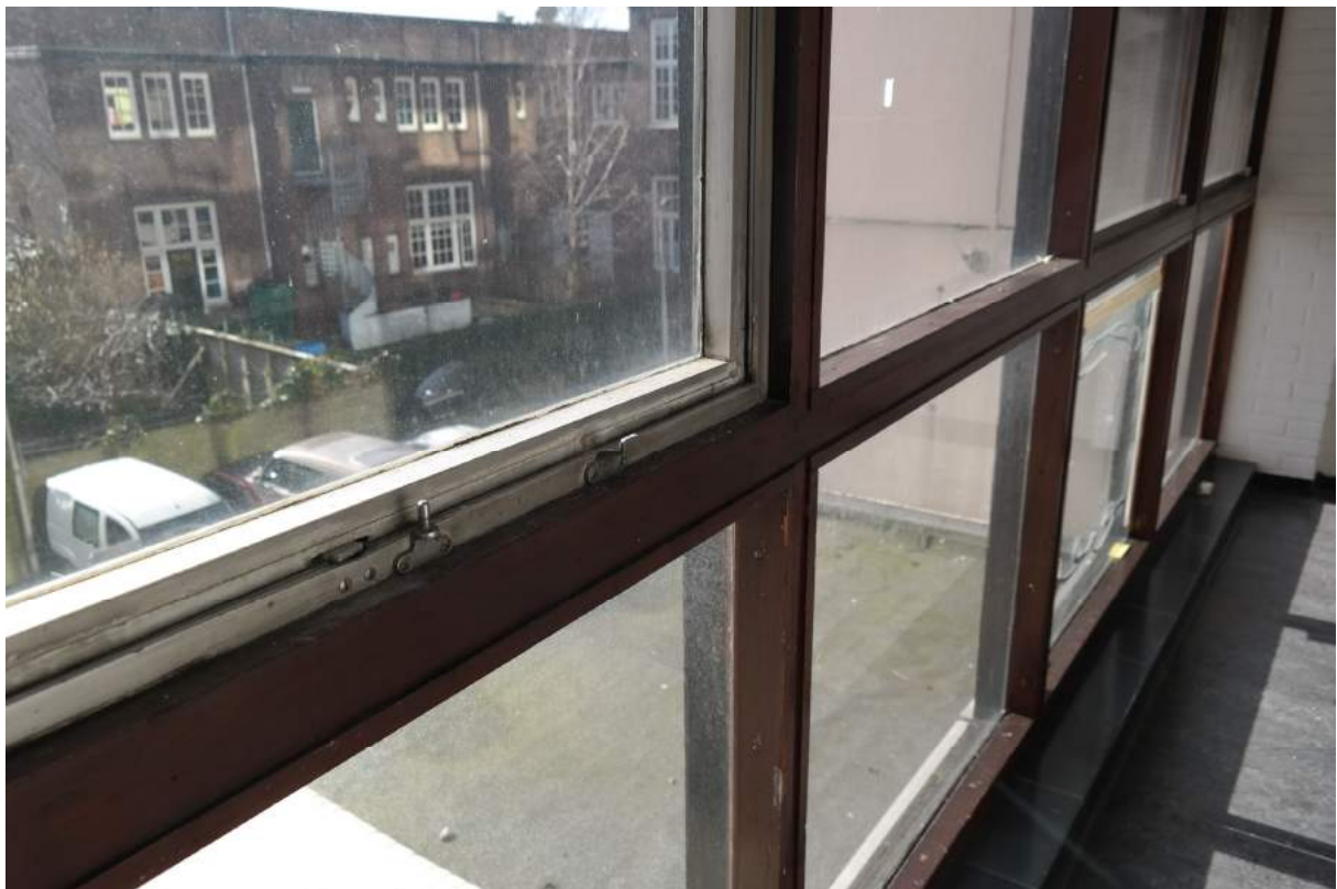
In het tussenlid tussen trappenhuis en kantoorvleugel zijn de oorspronkelijke hardhouten kozijnen met blank geanodiseerd aluminium ramen nog zichtbaar.
