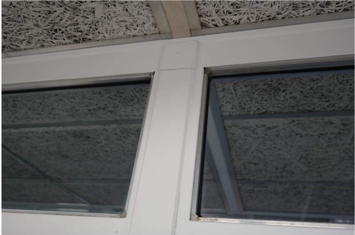
Detailfoto van het plafond en een bovenlicht in de systeemwand. Het plafond is nog ingeschilderd , de systeemwand is vermoedelijk in een later stadium witgeschilderd.
