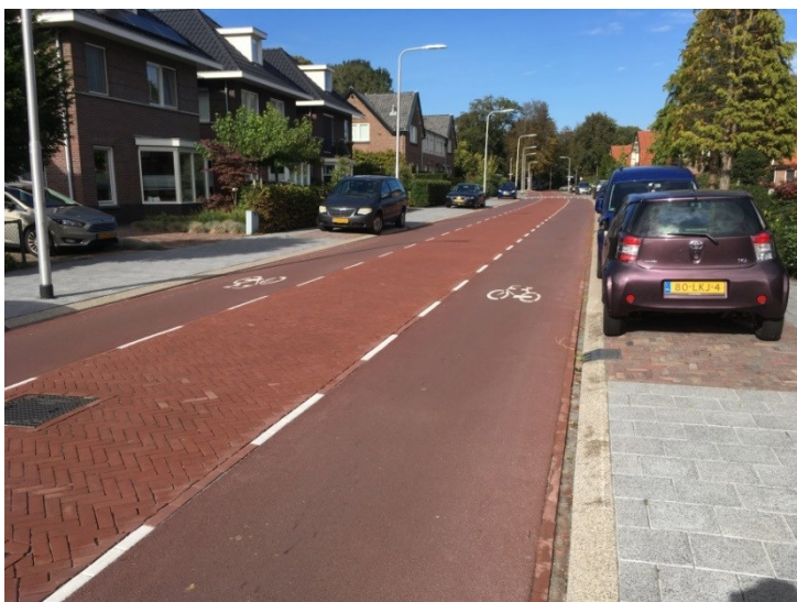
30km zone in Santpoort-zuid met overgang klinkers-roodasfalt
