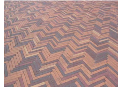
Foto 3.2.3.: Voorbeeld niet passende nieuwe klinkers: Amsterdam Zuidoost
