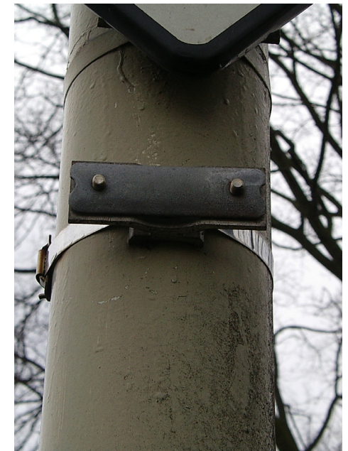
Bevestiging bestaande lichtmasten
