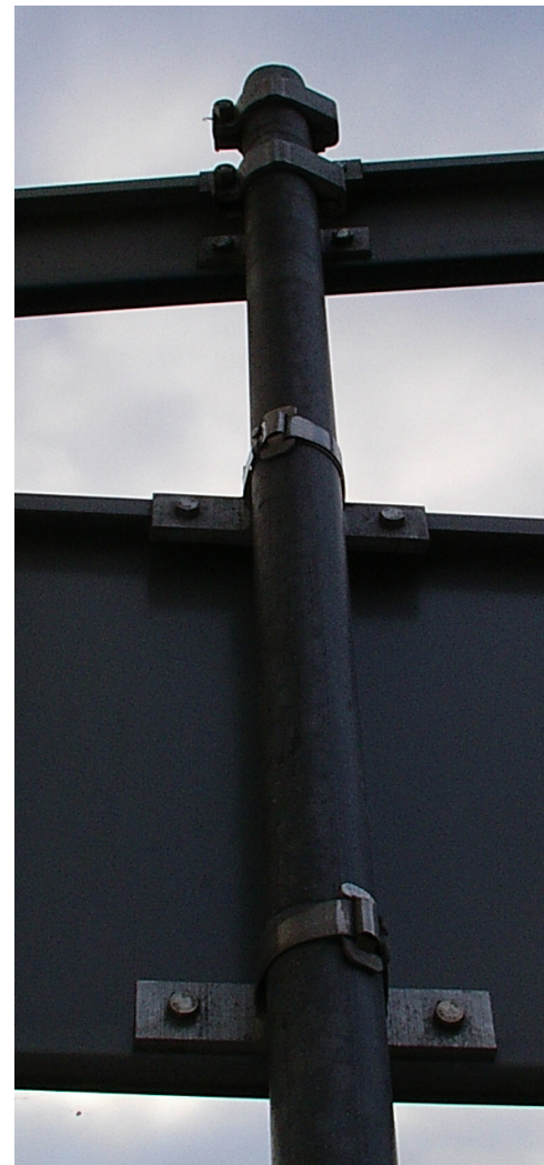
Bevestiging bestaande palen
