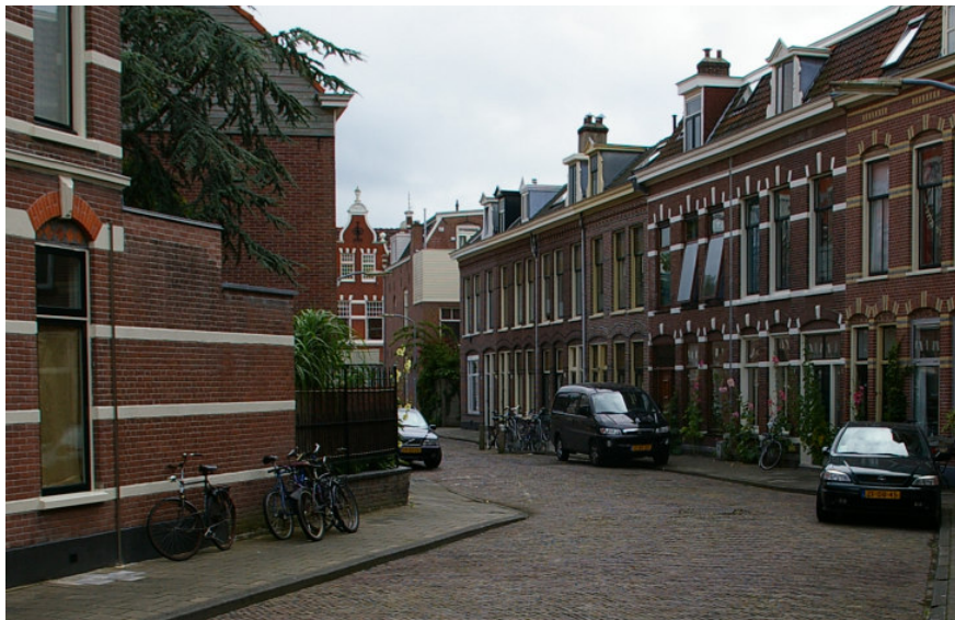
Heldere oorspronkelijke vloerpatroon: gebakken klinkers en betontegels
