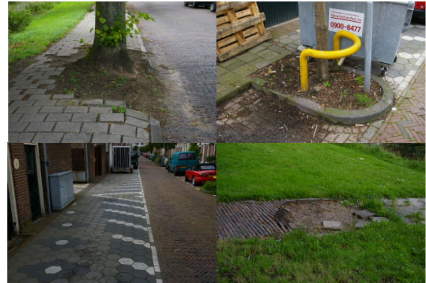
Onrustige openbare ruimte door ad hoc inrichting en achterstallig onderhoud
