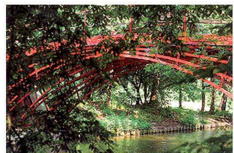
brug over Fuikplas
