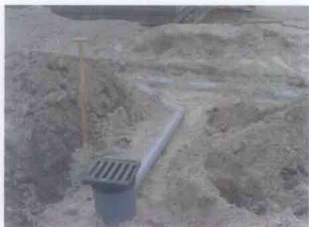
foto van het aanbrengen van een kolk.
