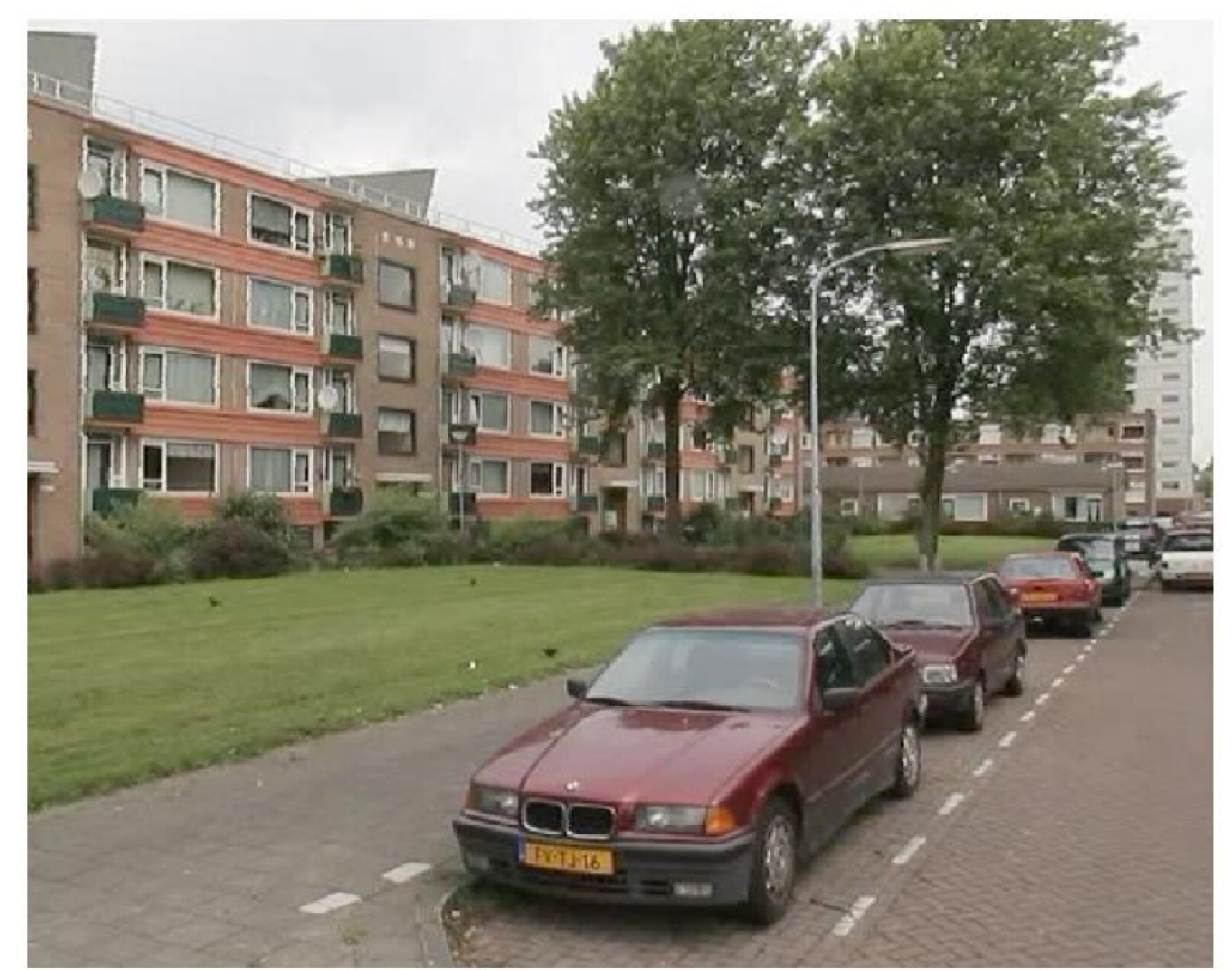
Noorwegenstraat huidige situatie
