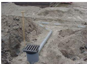
foto van het aanbrengen van een kolk. Zie figuur 6
