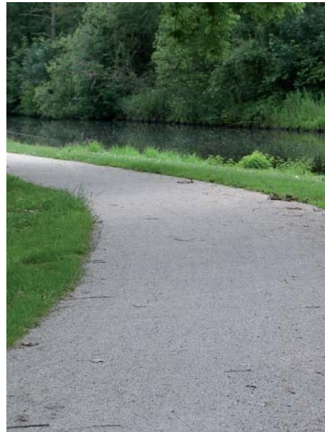
asfalt afgestrooid met mineraalgrit
