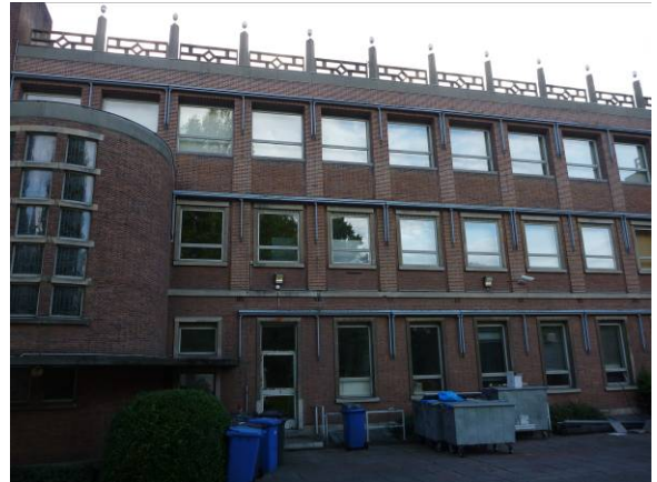
Figuur 3. Het te renoveren pand, gezien vanaf achterzijde
