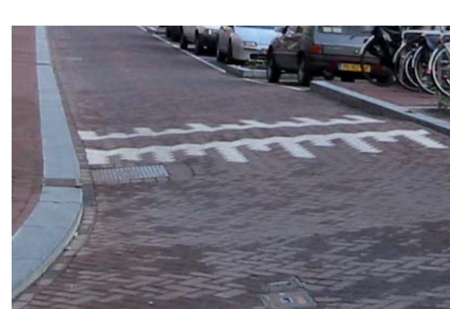
Drempel uitgevoerd in klinkers
