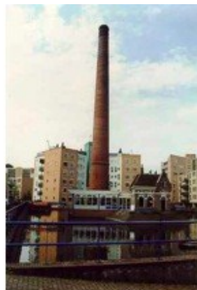
Hergebruik schoorsteen te Almelo
