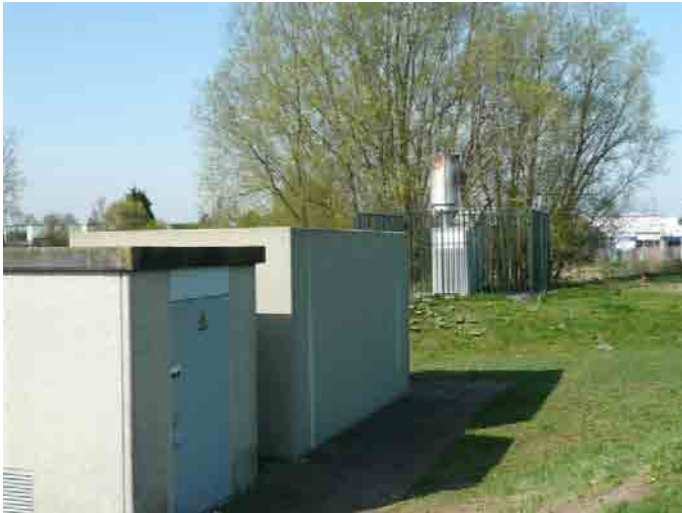
trafoge bouw, meetgebouw en gasfakkelinstallatie
