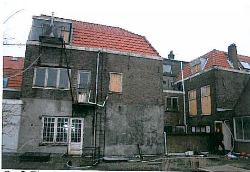
Foto B: Zijgevel van Spaarne 84 met toegangsdeur en achtergevel Spaarne 86 met toegangsdeur naar platte dak van de achterbouw.
