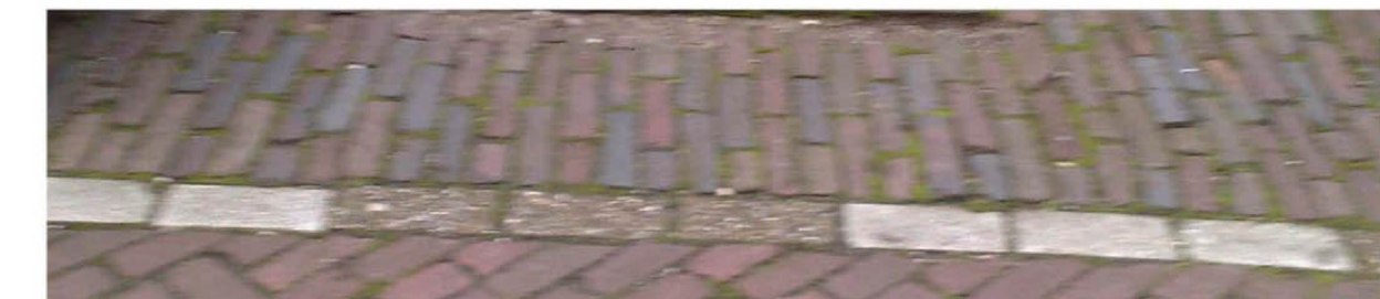
parkeervakken kwf halfsteens oud (hergebruik)
