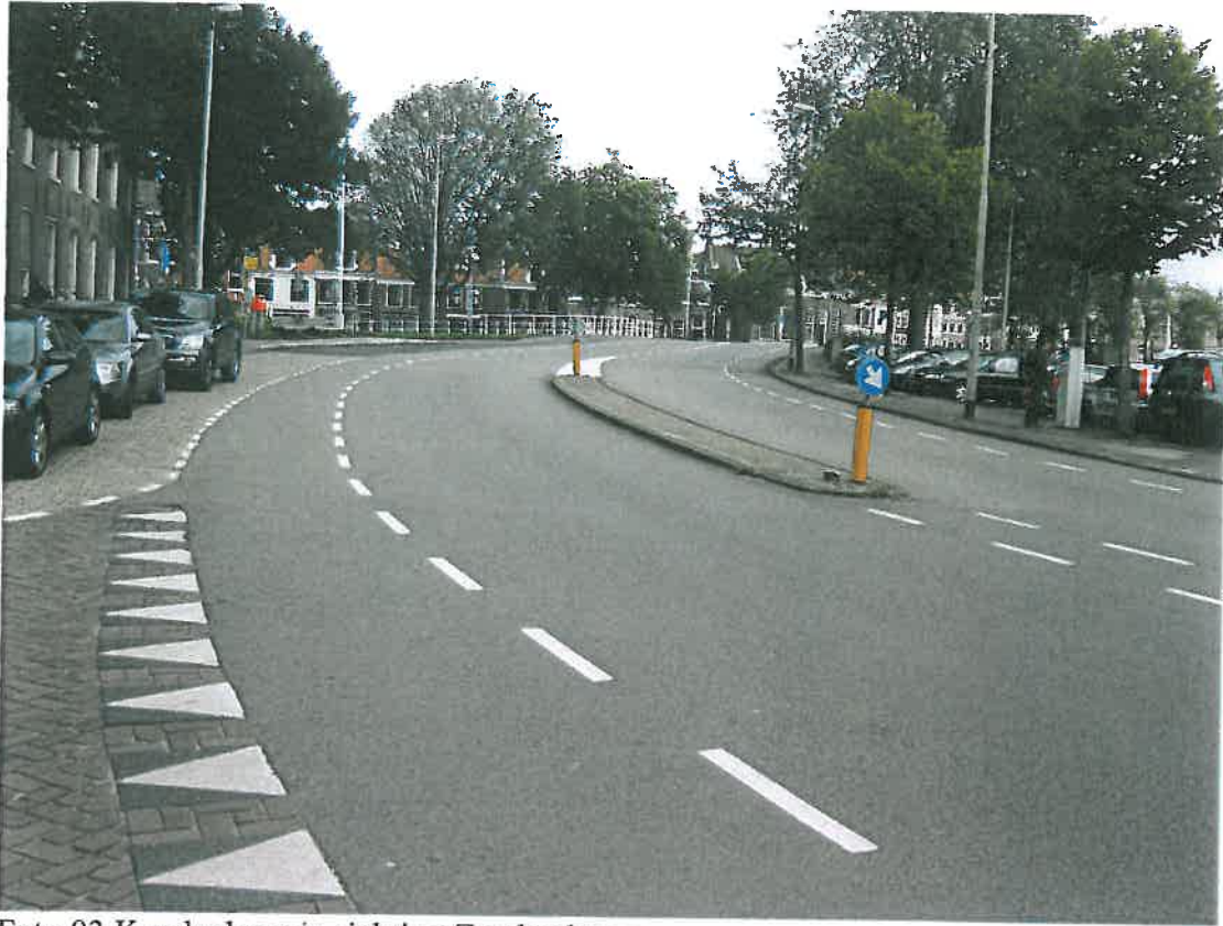
Foto 03 Koudenhorn in richting Zandersbrug
