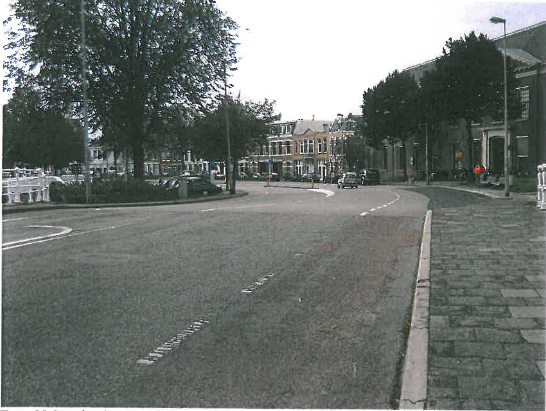
Foto 02 Zandersbrug in de richting van de Koudenhorn
