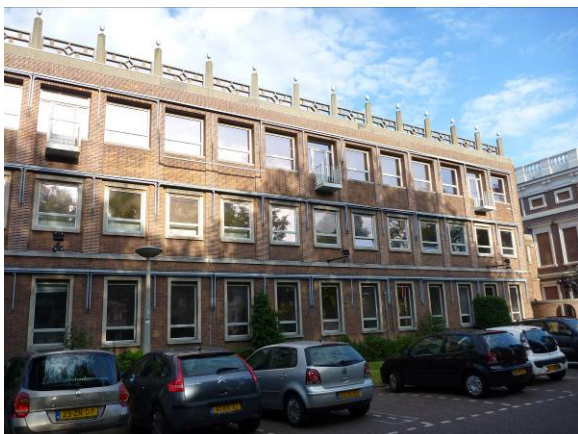
Figuur 2. Voorzijde van het te renoveren A-gebouw, gezien vanaf de parkeerplaats
