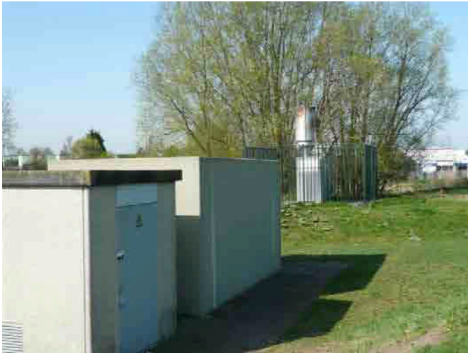
trafoge bouw, meetgebouw en gasfakkelinstallatie
