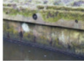
Damwand, hout onverankerd NBS0202 Glooiing beton
