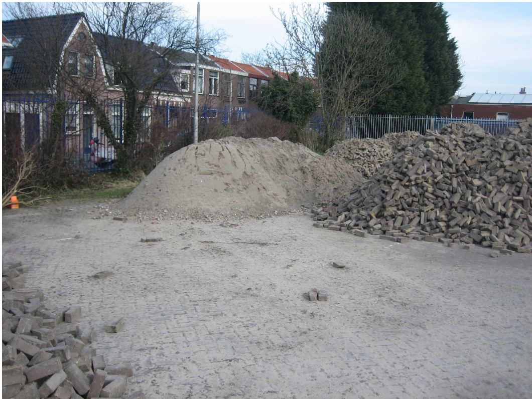
Foto 4: Hopen met grond en klinkers op het noordelijk terreindeel
