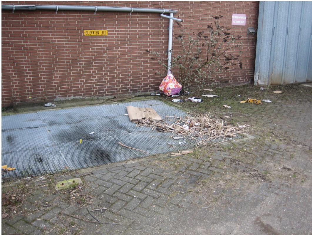
Foto 5: Olievatenopslag aan de westzijde van de werkplaats
