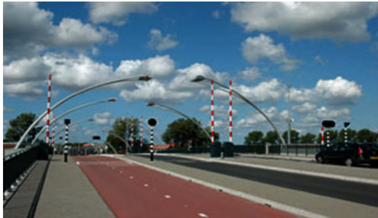
Betere bereikbaarheid Waarderpolder door Schoterbrug
