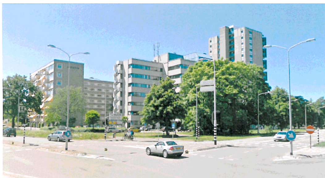
Afbeelding 2. Het bestaande gebouw gezien vanaf de het kruispunt Westelijke rand weg met de Wagenweg
