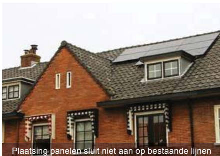
Plaatsing panelen sluit niet aan op bestaande lijnen
