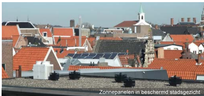
Zonnepanelen in beschermd stadsgezicht
