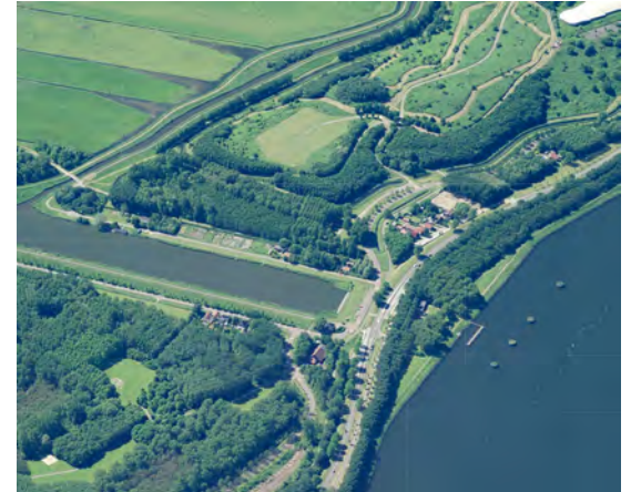
Aansluiting linedijk op Noordzeekanaal - huidige situatie
