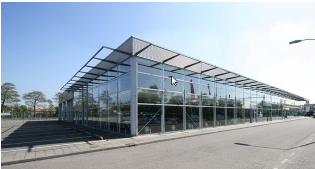
Afbeelding 2: Het pand Eysinklaan 63/65.
