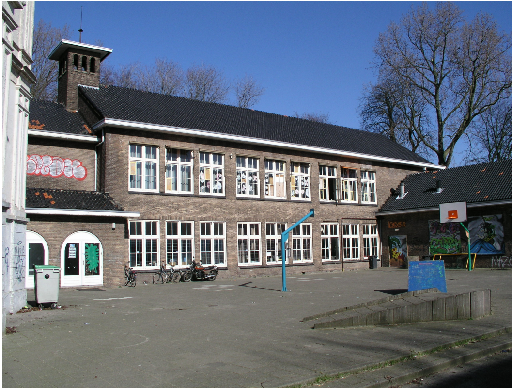
Kavel 2 - Bolwerkkavel (vm. schoolgebouw slopen)
