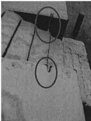
Fig. 3 Wijken van de kademuur aan beide zijde van de trap (rode cirkels)
