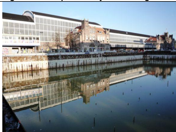
Figuur 1. Bouwput voorzijde stationsgebouw
