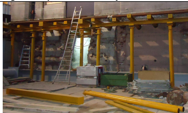
Figuur 6. Opbouw van het vizelframe
