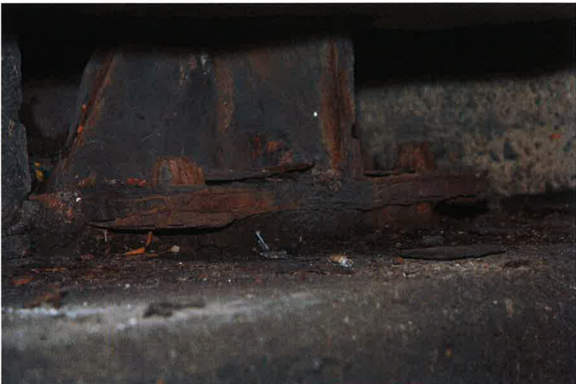
Draaipunt brug verankering grondplaat vertoont veel corrosie. (foto boven en onder)
