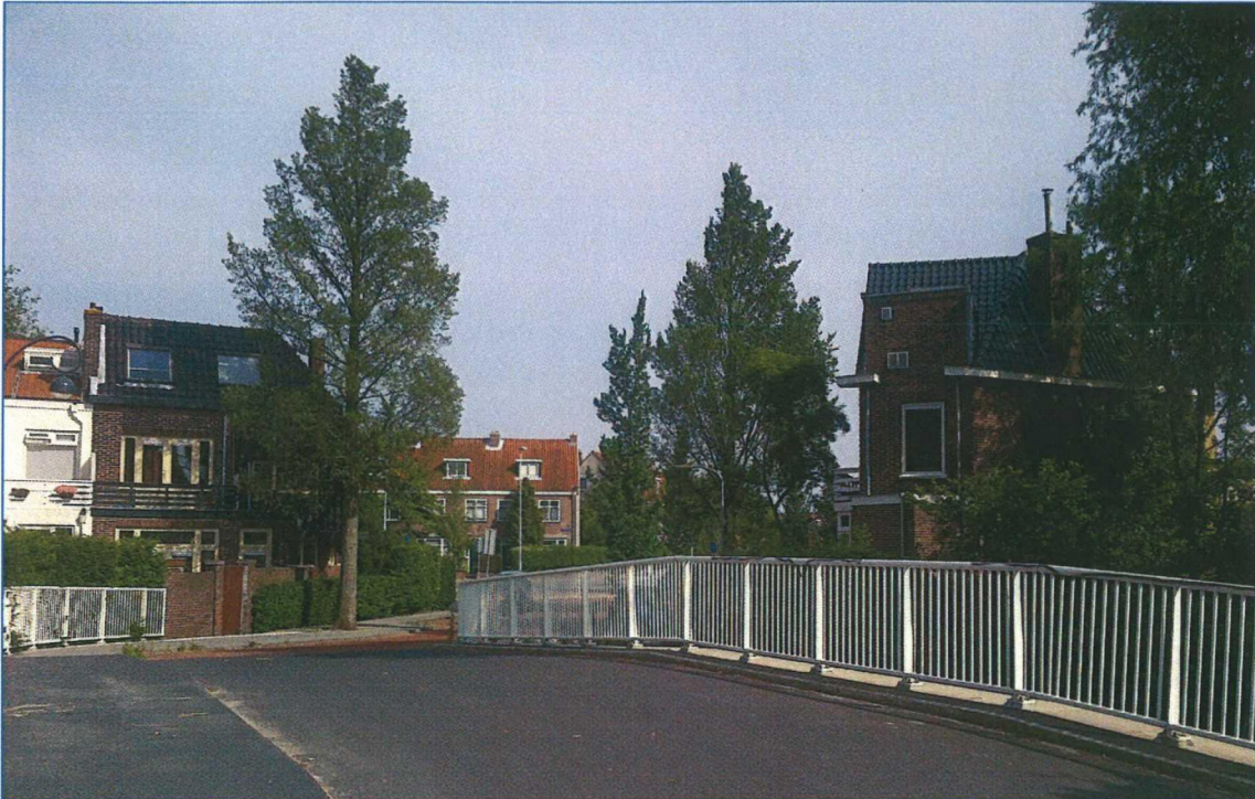
Figuur 6 Foto van de gerealiseerde brug en het object van aanvragers.
