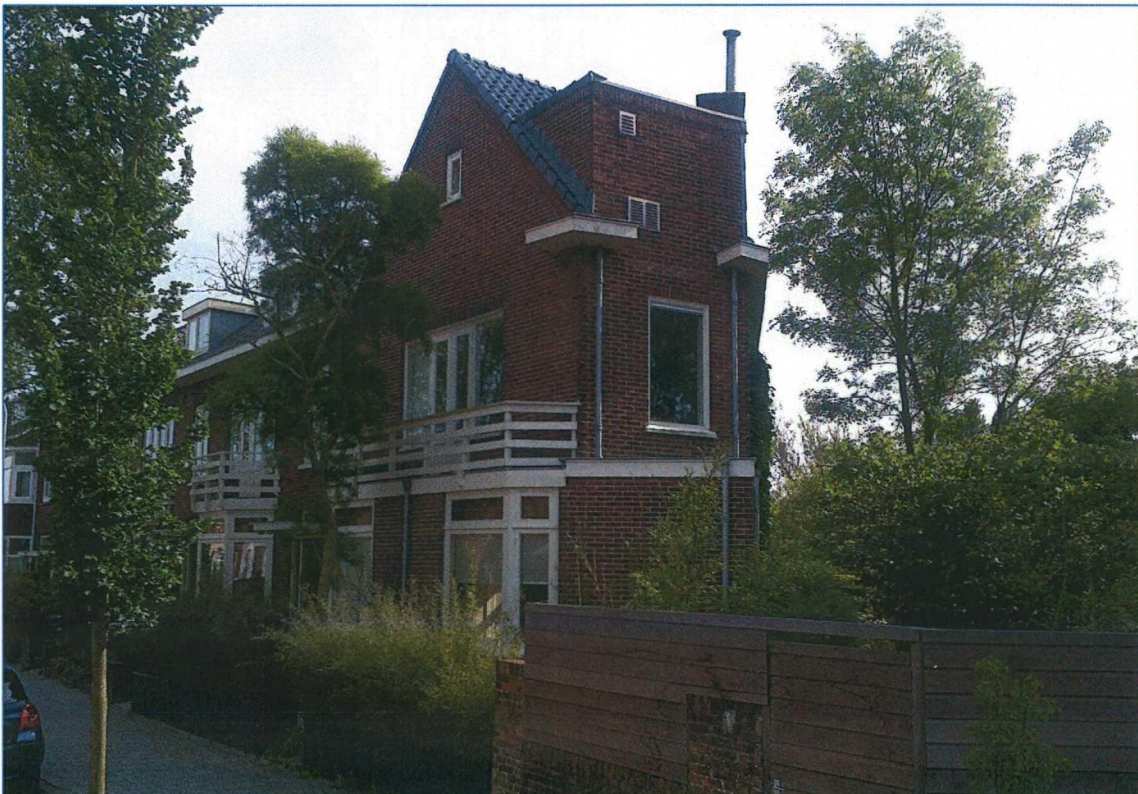
Figuur 7 Foto van de zij-/ voorgevel van de woning.
