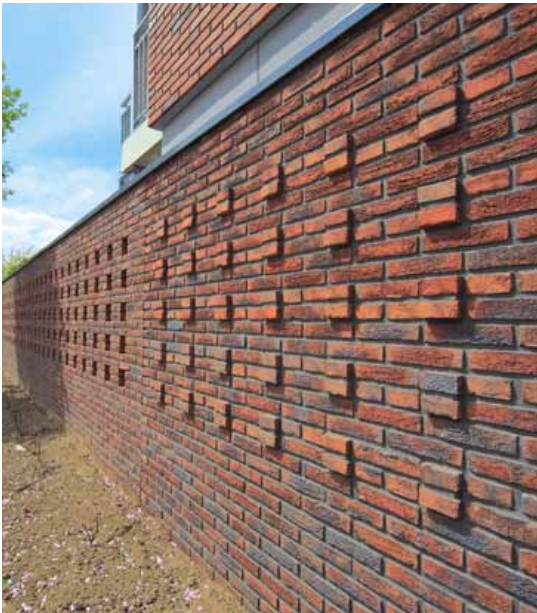
Voorbeelden van bijzondere verbanden in het metselwerk op koppen
