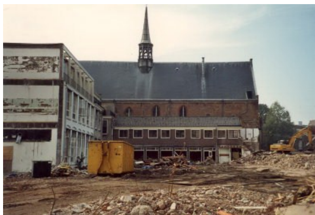
Voorbereiding sanering Janskliniek
