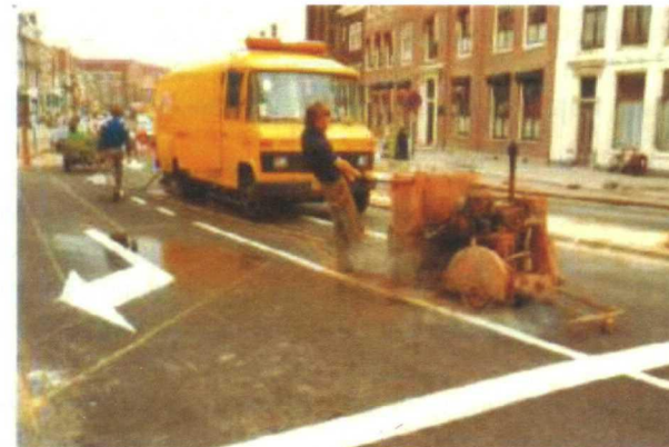
Figuur 3 Aanbrengen detectielussen
