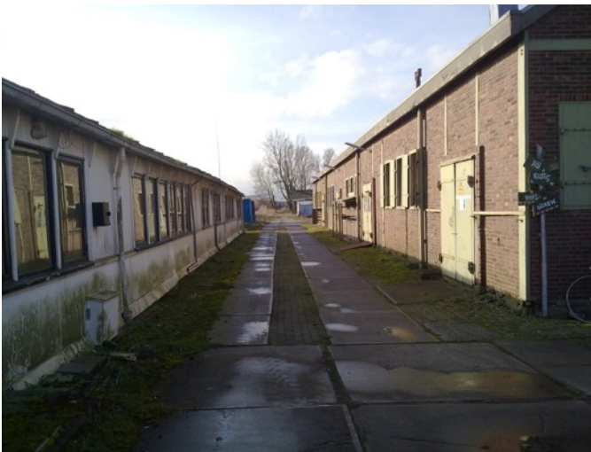
Lange gevel van de werk- en opslagloods
