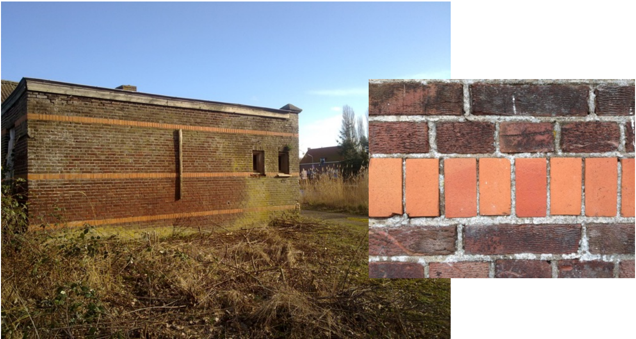
Links de westelijke zijgevel van de vetsmelterij, rechts deel van het siermetselwerk.
