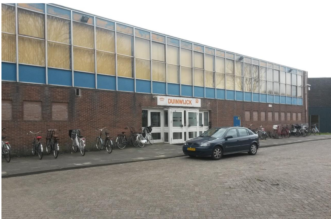
Figuur 3. De voorzijde van de sporthal bestaat uit een gedeeltelijke stenen gevel zonder dilatatievoegen en ramen.
