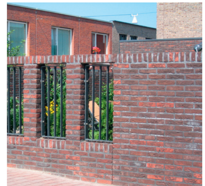
gemetselde bergingen op markante hoeken
