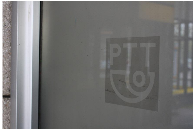
Westgevel en details voormalige publiekentree van het postkantoor.
