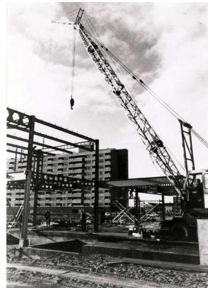
Bouw van het winkelcentrum, gezien naar het westen, 1970 (Noord-Hollands Archief Hrlm-20068)
