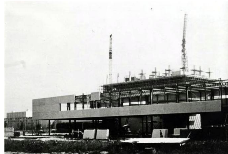
Eén van de tweelaags bouwdelen tijdens de bouw in 1970 (Noord-Hollands Archief Hrlm-20071)
