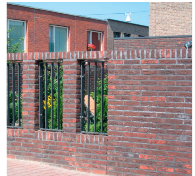
gemetselde bergingen op markante hoeken
