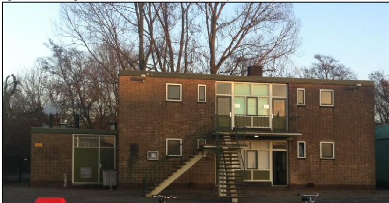
figuur 2. Huidige kleedaccommodaties (bouwjaar 1966)
