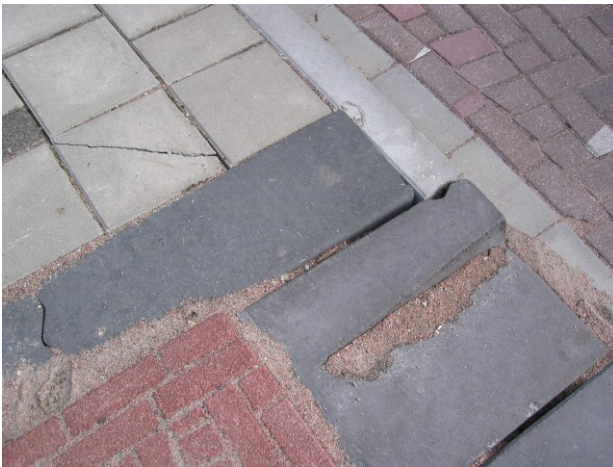
Foto 3.3.1: Voorbeeld gebrekkige detaillering: Meerwijk Centrum
