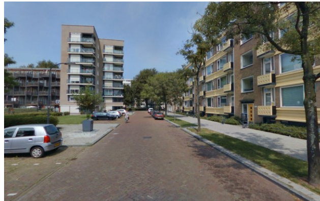
Foto.1.1.1 Fraaie openbare ruimte Schalkwijk
