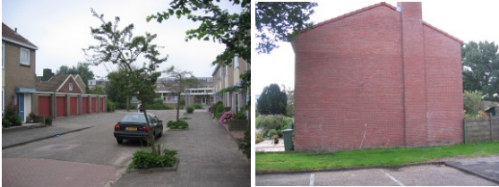
Foto 3.5.2: kwijnende bomen, blinde gevel: boom plaatsen
