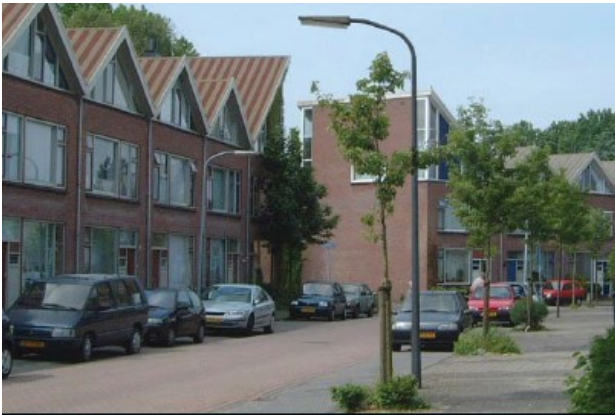
Foto 3.6.3: Standaard woonstraatmast past in Schalkwijk
