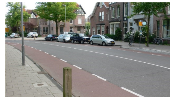
Foto 3.3.4: asfalt straat Noord (Ostadestraat.)
