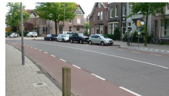
Foto 3.3.4: asfalt straat Noord (Ostadestraat.)
