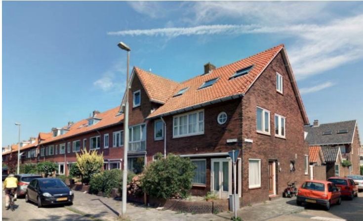
Afbeelding 11: woonblok langs de Jan Gijsenkade. Bron: Cyclomedia ©
