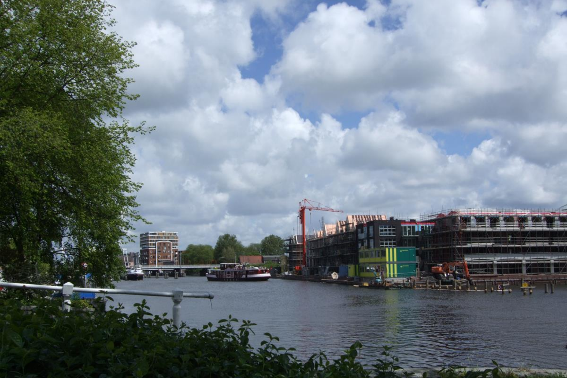
Kop van het stedenbouwkundig motief
